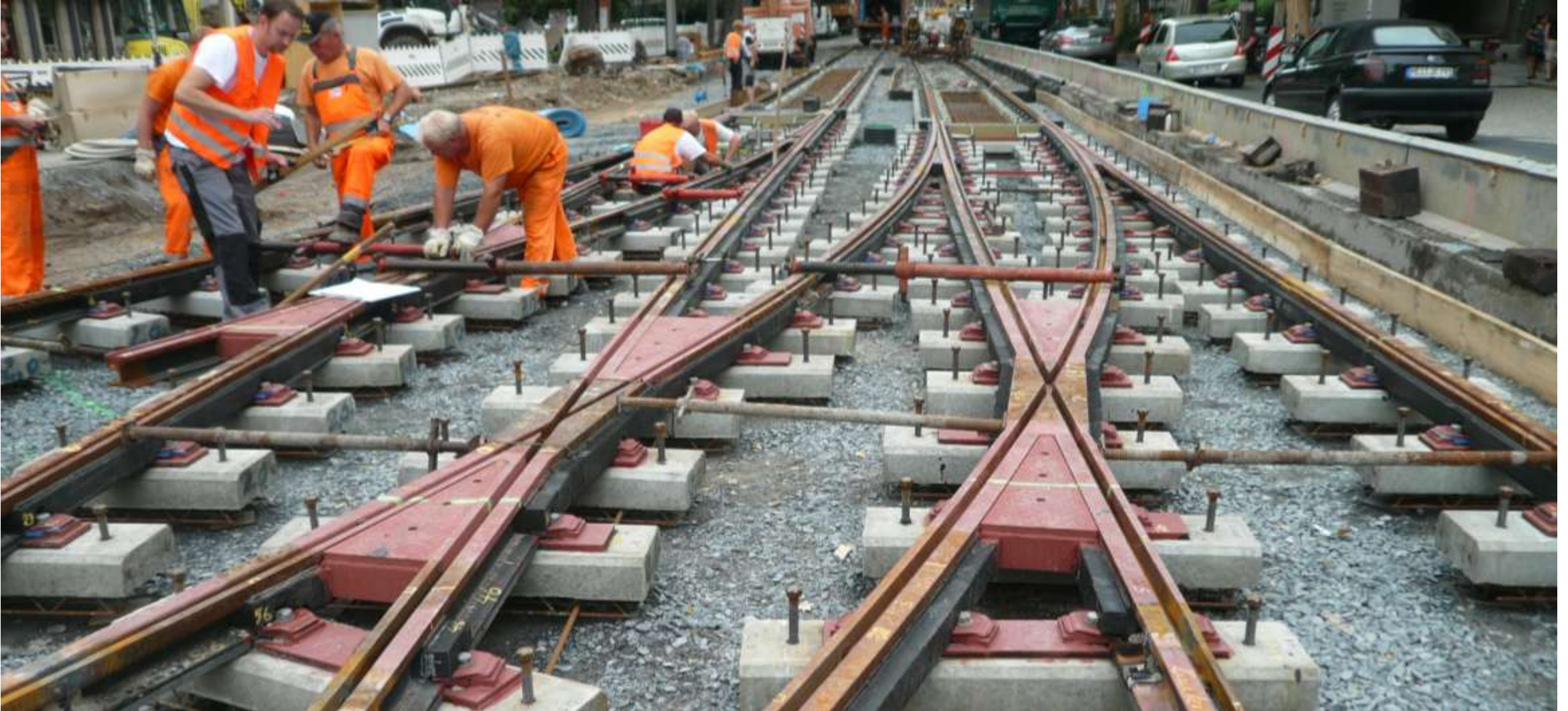
Weiche auf Kurzschwellen, Bautzner-/Hoyerswerdaer Straße (2013)
