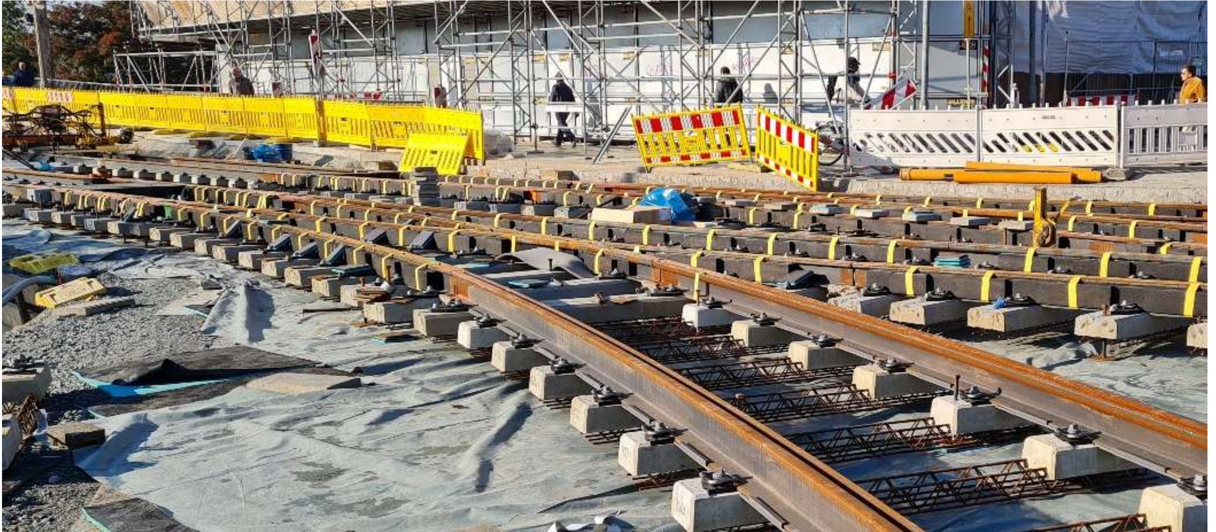
Weiche auf Halfenschwellen und elastischer Unterlage, Augustusbrücke 2021
