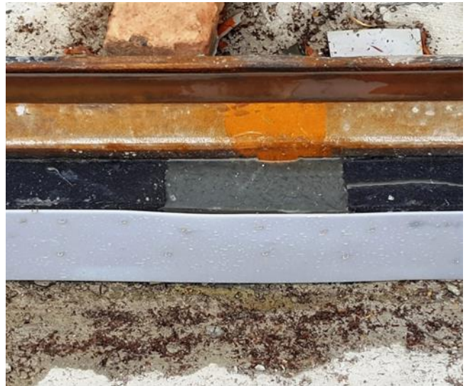
Schienenschweißstoß mit e)(s PurFlex
