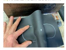
Den Mittelpunkt des Abdeckstreifens auf die Schraube aufsetzen und festhalten. Die Flächen nun an die Schienenbefestigung andrücken. Die Falten ober und unterhalb der Schraube fest zusammendrücken.
