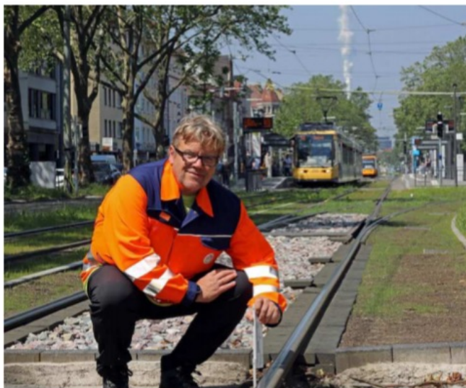
Hier grau, da grün: Karsten Reichenbacher zeigt in der Kaiserallee beim Mühlburger Tor die Unterschiede von Schotter und Rasen im Gleisbett. Foto: Jörg Donecker
