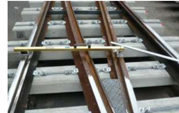
Abnahme von Konstruktionen beim Hersteller und auf der Baustelle
